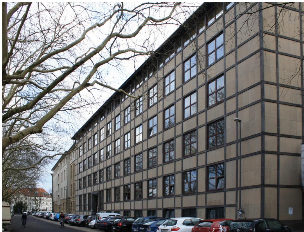
Abb. 46 Aachen, Intzestraße 5, RWTH, Gießerei-Institut, 1951, erneuertes Steinfachwerk in Ettringer Tuffsteinplatten mit Gliederungen und Sockel aus Basaltlava
