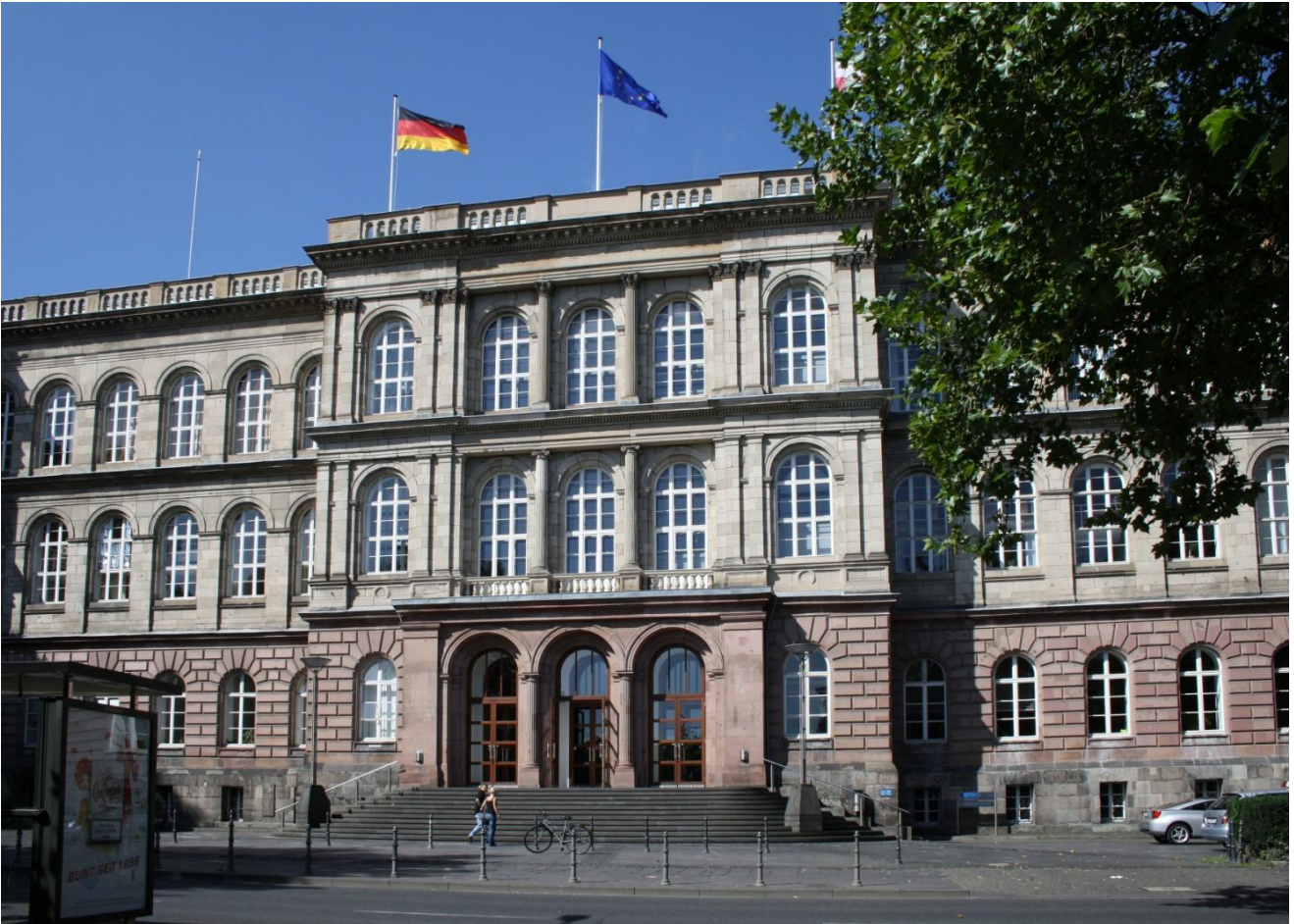
Abb. 20 Aachen, RWTH, Hauptgebäude am Templergraben, 1870
