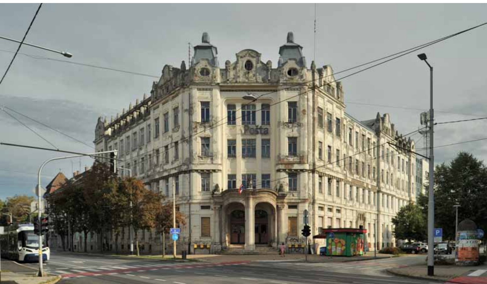
▲ Abb. 4: Postamt an der Europastraße, erbaut 1912.
