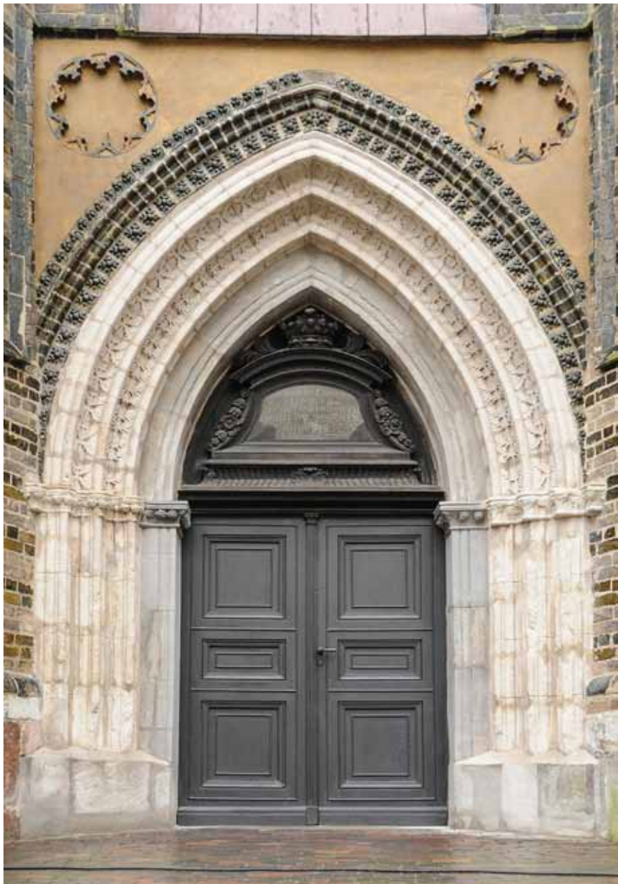
► Abb. 5 | oben: Anlegen einer Musterfläche zur Injektion von Mörtel.
