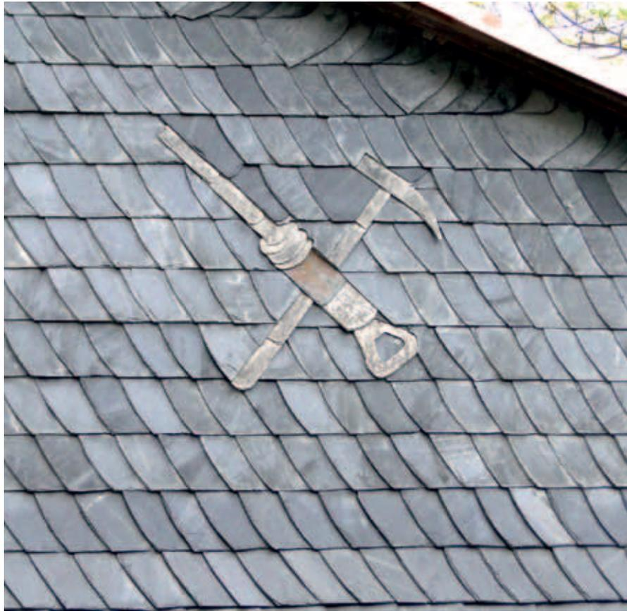
**Abb. 12.** Ornamentdeckung an der ehemaligen Spalthalle (sog. Hütte) von Schmiedebach mit grün-silbrigen und schwarzgrauem Schiefer aus Thüringen in altdeutscher Deckung mit stumpfem bzw. Thüringer Hieb.
