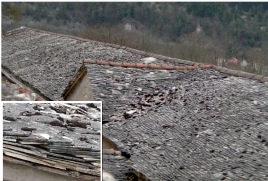
**Abb. 18.** Ein Legschieferdach auf einem Jurahaus, dabei handelt es sich um dünn gespaltene Kalkplatten aus dem Oberen Jura. Links Dachdetail mit 5facher Überdeckung (Innenstadt von Eichstätt).
