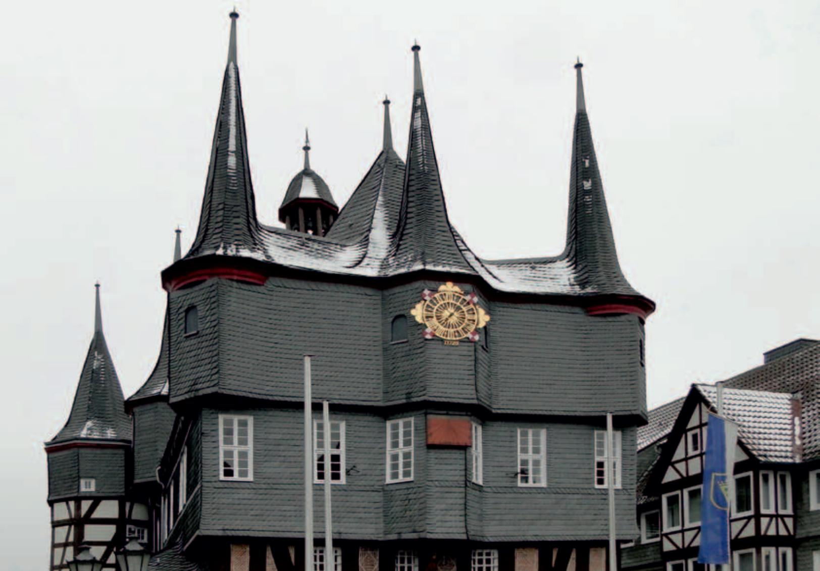
**Abb. 6.** Das Schiefergedeckte und -bekleidete Alte Rathaus von 1513 in Frankeberg/Eder, sowohl ursprüngliche Deckung als auch Neueindeckung ab 2010 mit Westfälischem Schiefer (Mitteldevon).
