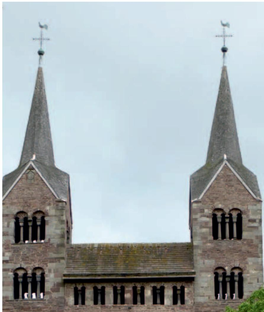
**Abb. 8.** Sollingplatten (Sandsteinplatte aus dem Mittleren Buntsandstein, Trias) in englischer Random-Deckung auf dem Westwerk des Klosters Corvey.
