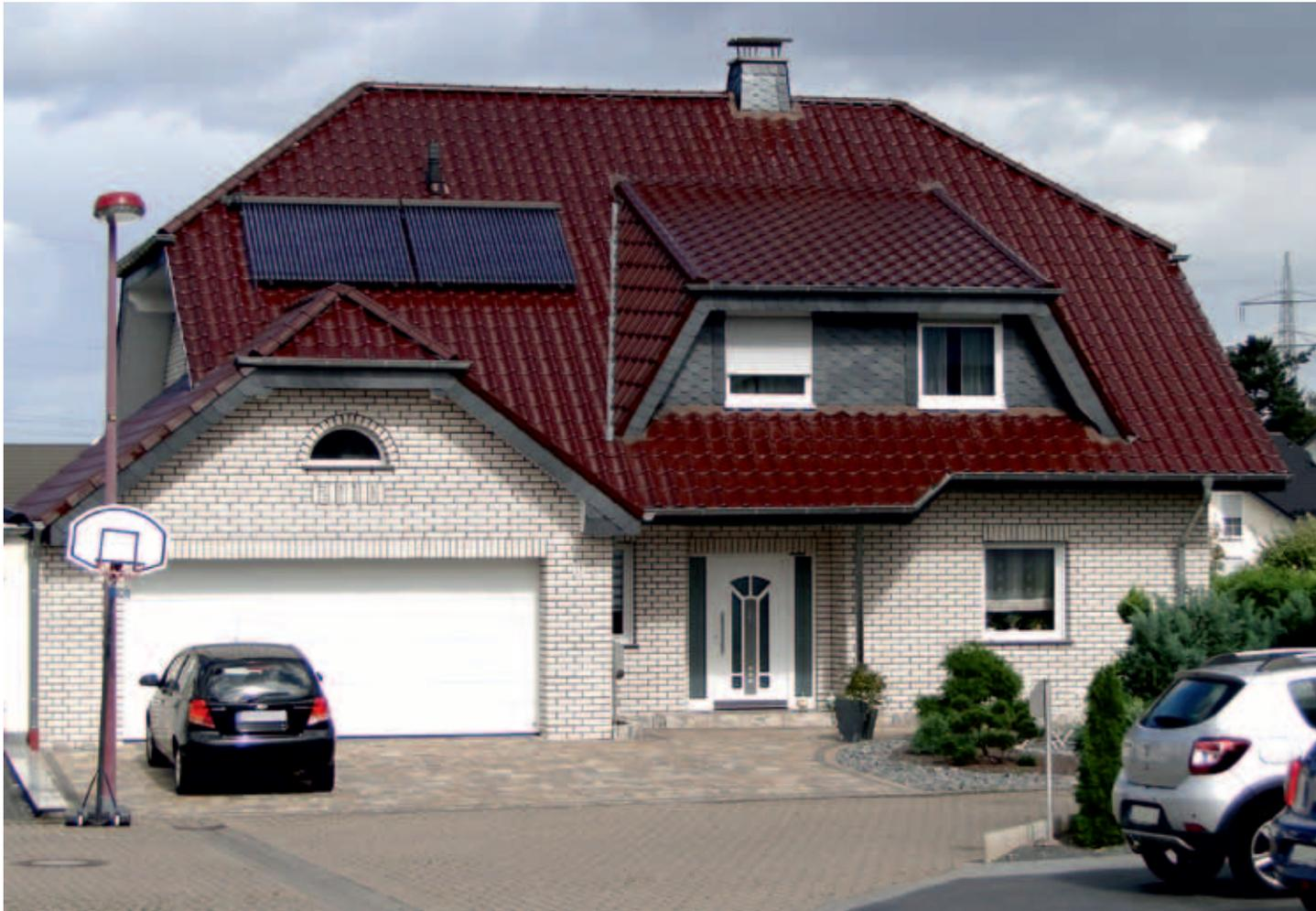
**Abb. 19.** In einer Schiefer-Landschaft: Während der Spiegel der Gaube, Schornstein und Sparrenbekleidung noch vorbildlich mit Schiefer in Wabendeckung bekleidet sind, besitzt das Dach Ziegel in neuer Farbe und mit glänzender Oberfläche.
